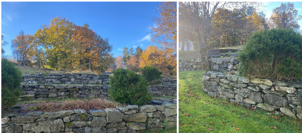
Figur 4.16. Terrassert hageanlegg på Lindøy. Foto tatt av Metteline Dydland Larsen i 2024.
