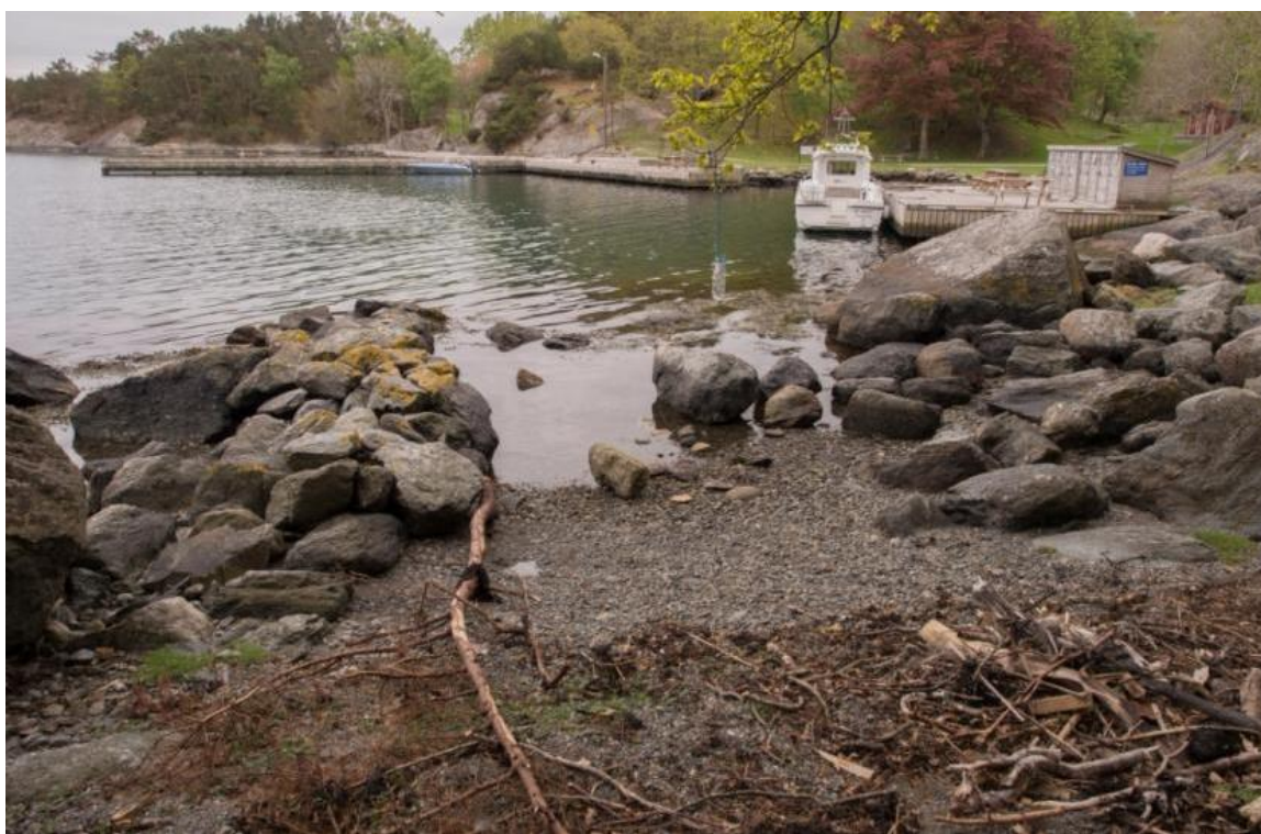
Figur 4.17. Foto fra 2014. Eldre båtopptrekk med noe utrast stein. Tilrettelagt bryggeområde i bakgrunnen.
